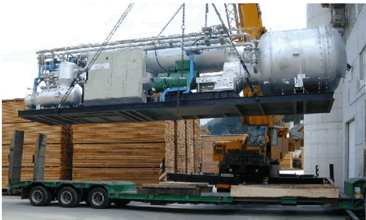
図 15 : OCR パワープラント <18> 、出典: Turboden, Brescia, Italy.
